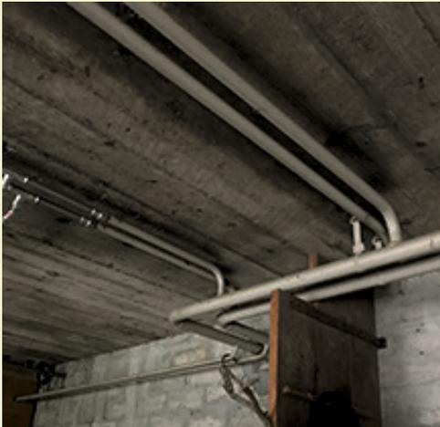
Weder die alten noch die neuen Heizleitungen sind auf dem Bild oben gedämmt und dadurch geht unnötig im Keller Wärme verloren. Die Dämmung lohnt sich, denn die Kosten für das Dämmmaterial und für den Arbeitsaufwand sind rasch amortisiert.
