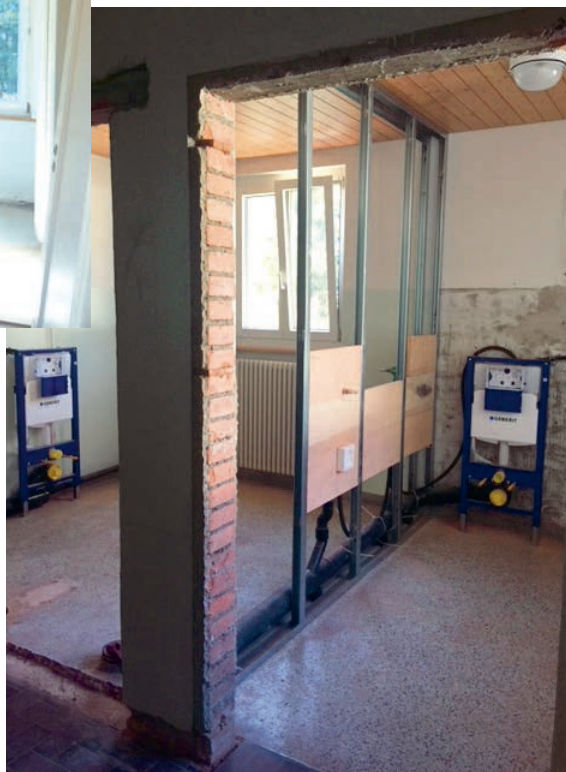
Sanierung Schulhaus Baggwil
